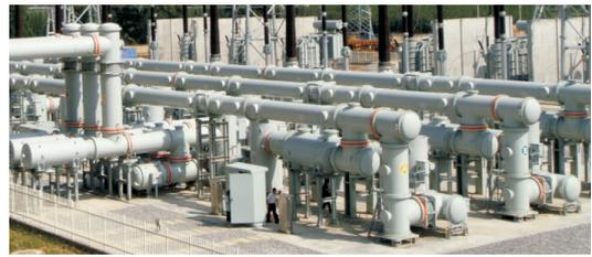
图1 气体绝缘开关设备
